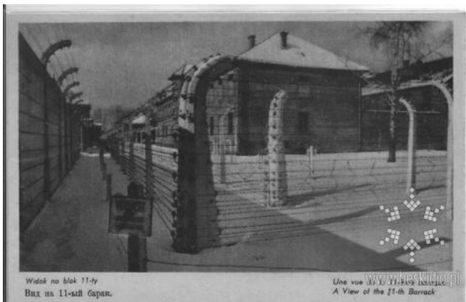
Widok na blok 11-ty
