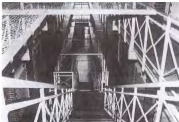
Rawicz – pawilon II „czerwony” – widok ze środka, z 3 kondygnacji
